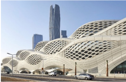
شكل (7) البناء الخارجي لمحطة كافد، زهاء (حديد 2024، Bitar)
