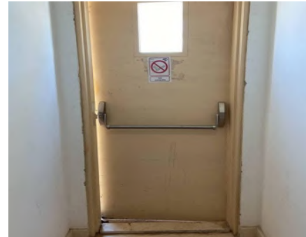
الصورة 5.3 مخرج الطوارئ
