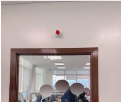
الصورة 5,2 مستشعر بصري للحرائق مناسب للأشخاص الصم وضعاف السمع
